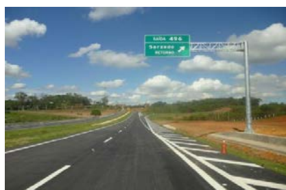
Betim Beltway (Autopista Fernão Dias)
