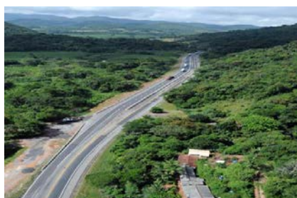
Duplication of Serra do Cafezal (Autopista Régis Bittencourt)
