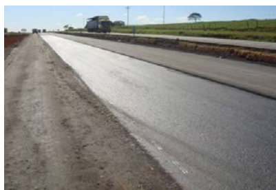
Duplication of BR101-RJ / Macaé – Campos (Autopista Fluminense)
