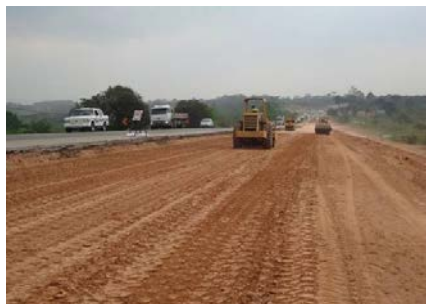
Duplication of BR-116/PR – Fazenda Rio Grande (Autopista Planalto Sul)
