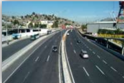
Avenida do Contorno (Autopista Fluminense)
