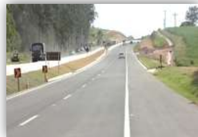
Duplication of BR101-RJ / Macaé – Campos (Autopista Fluminense)
