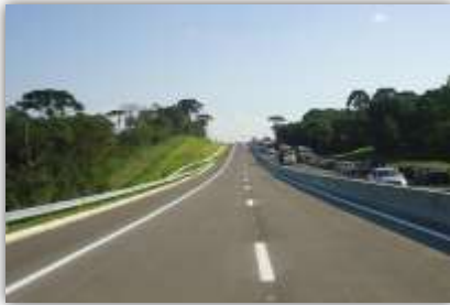
Duplication of BR - 116/PR (Autopista Planalto Sul)
