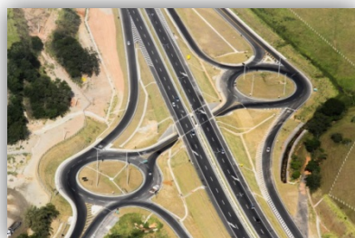
Duplicação BR101-RJ / Macaé – Campos (Autopista Fluminense)
